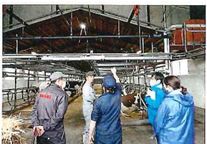
写真5 人の頭に配管が当たらないように埋め込むなど、安全へのコストは惜しまない
